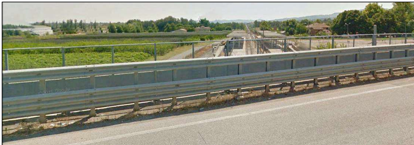
Immagine 2.3.2 – Foto del 2016 per la localizzazione del nuovo centro cinofilo in località Chiesa Nuova: vista della stazione RFI della BO-Vignola dal cavalcavia della SP569
