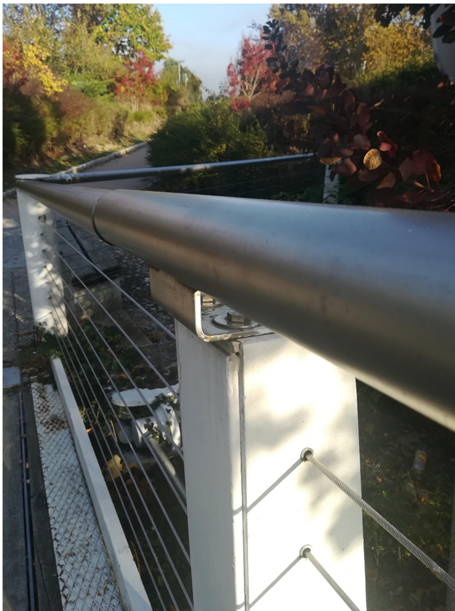
Dettaglio di sommità del montante tipico del parapetto
