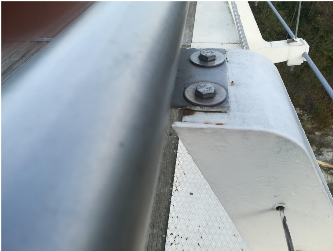
Dettaglio di sommità del montante tipico del parapetto
