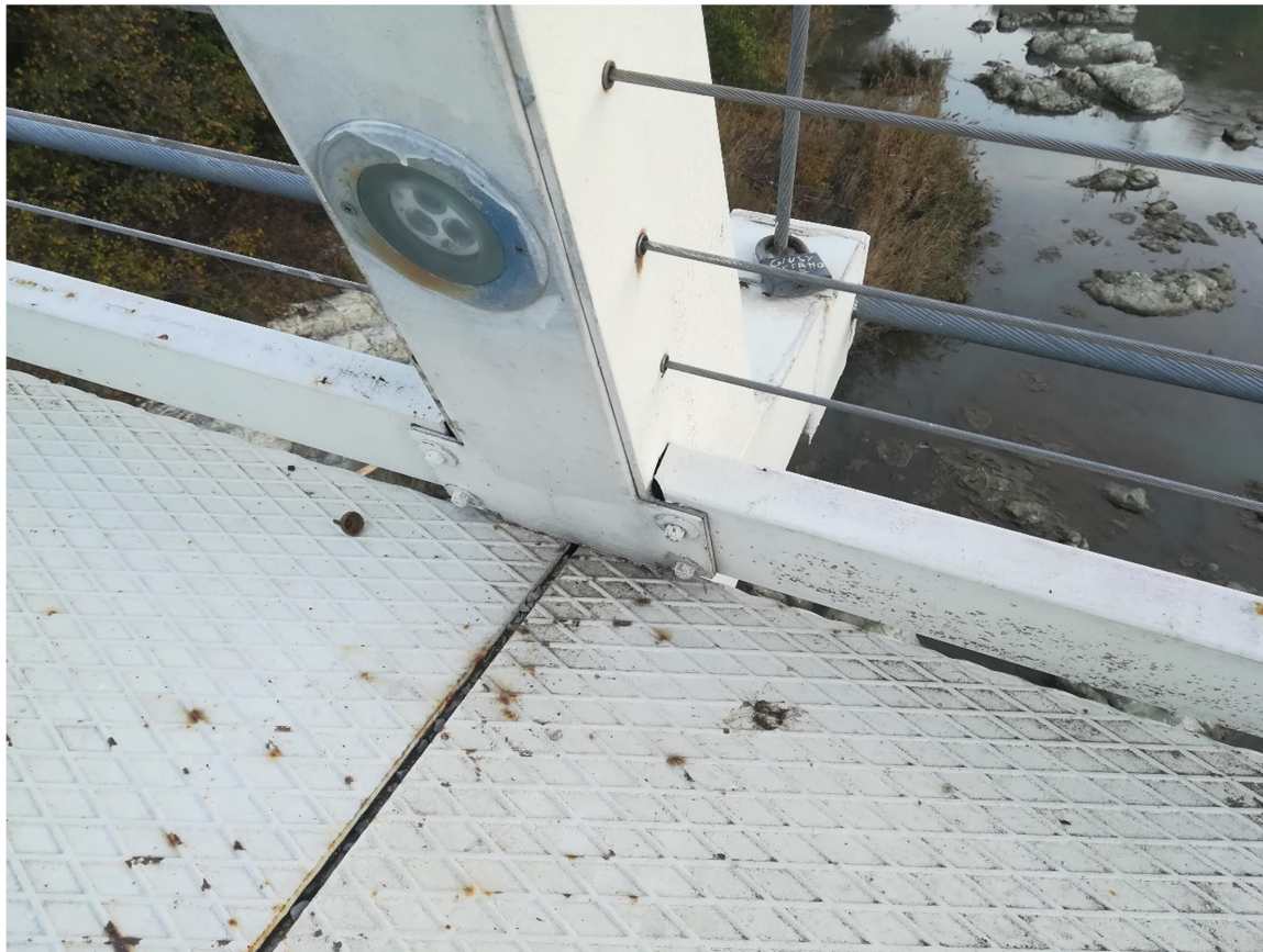
Dettaglio di base del montante tipico del parapetto
