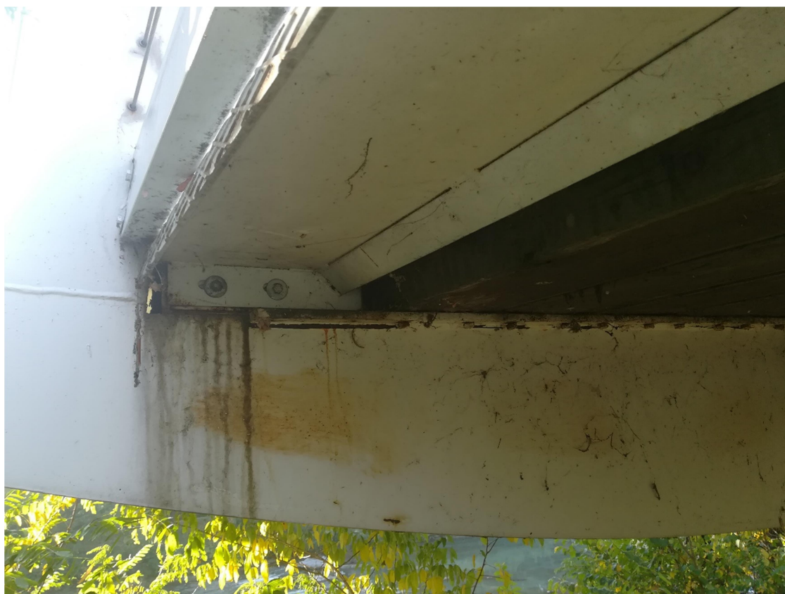
Particolare intradosso impalcato – Collegamento della lamiera antisdrucchiolo di bordo
