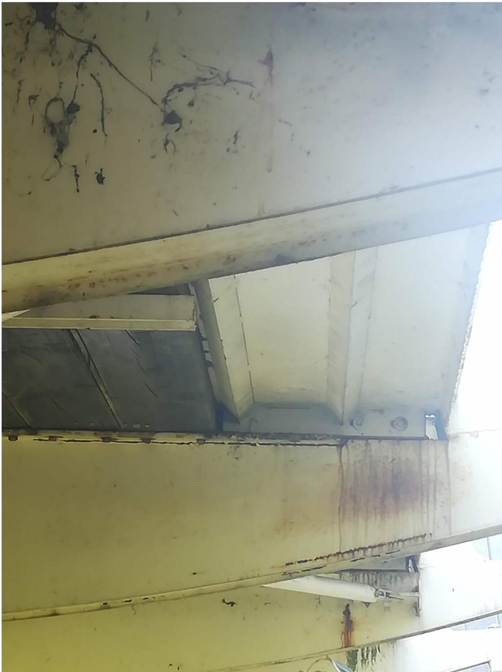
Particolare intradosso impalcato – Collegamento tra gondola trasversale e lamiera antisdrucchiolo nervata di bordo
