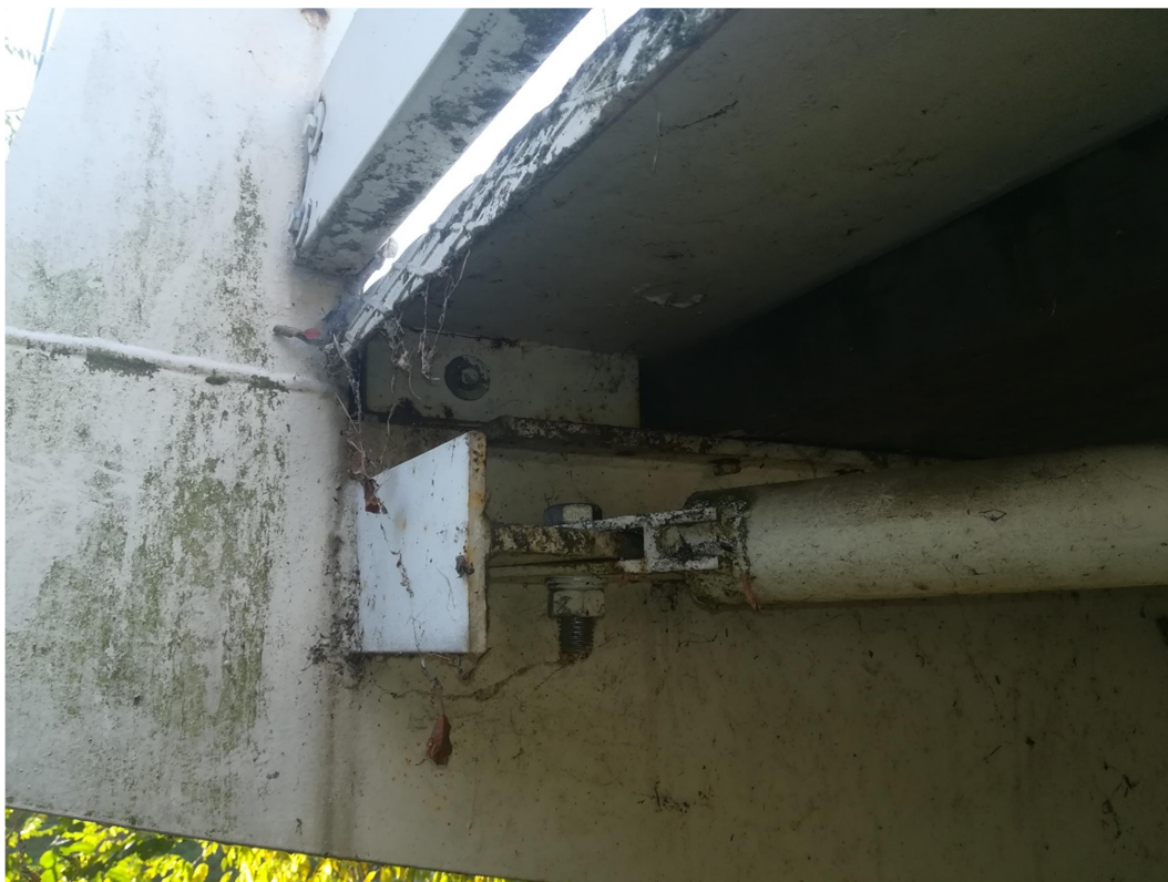
Particolare intradosso impalcato – Attacco controvento alla gondola trasversale, collegamento della lamiera antisdrucchiolo di bordo
