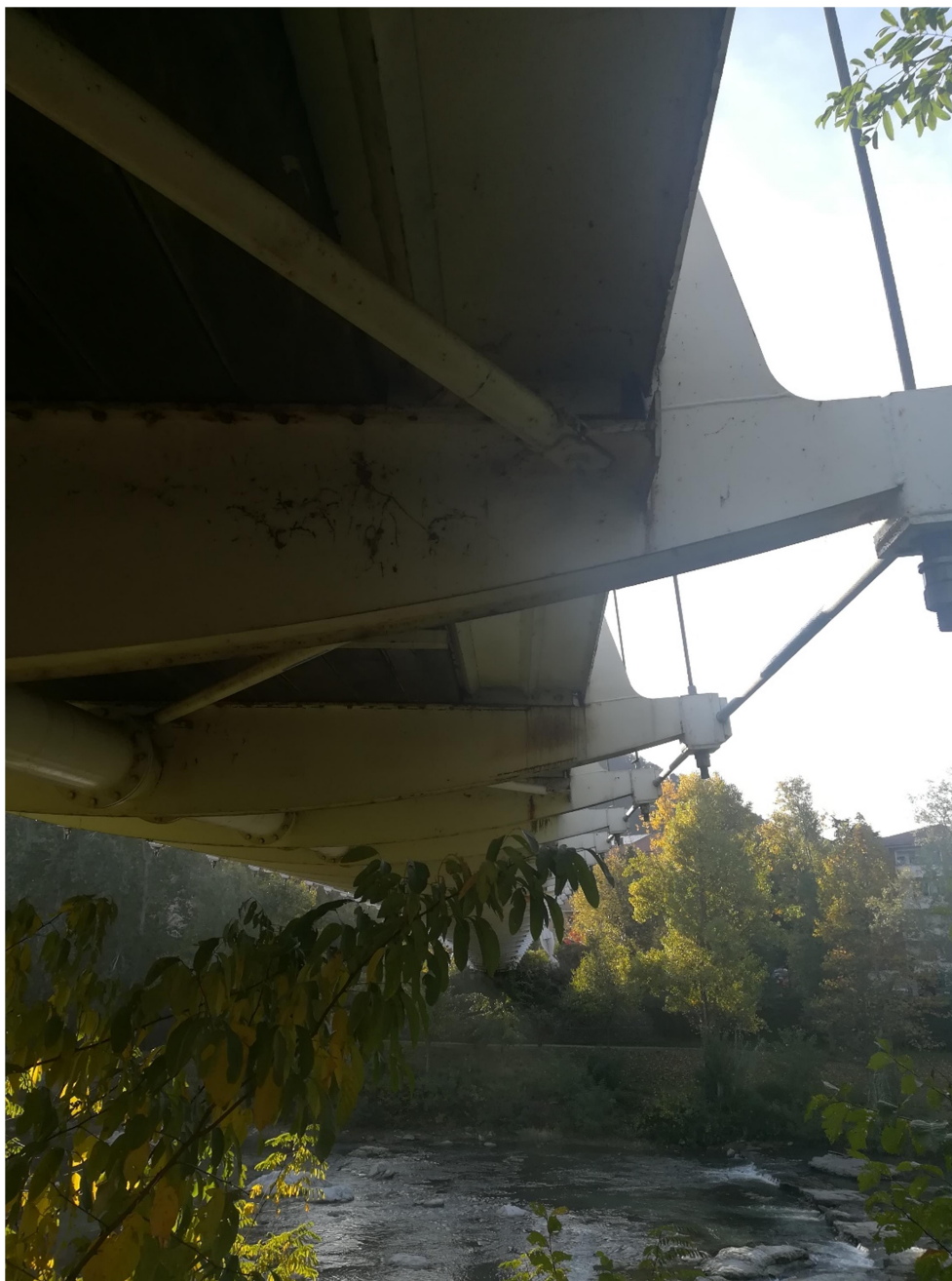
Particolare intradosso impalcato – Gondole trasversali e lamiere antisdrucchiolo di bordo
