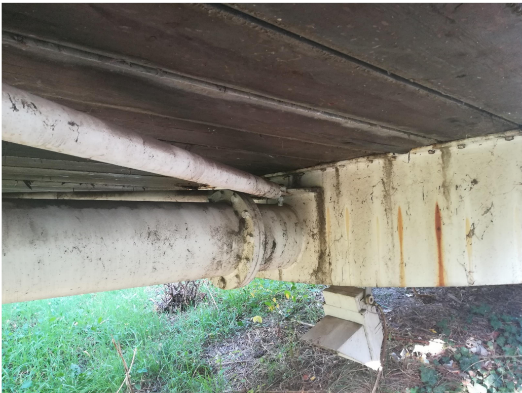
Particolare intradosso impalcato – Attacco tubo longitudinale e controventi alla gondola trasversale, appoggio delle doghe in legno sulla gondola trasversale
