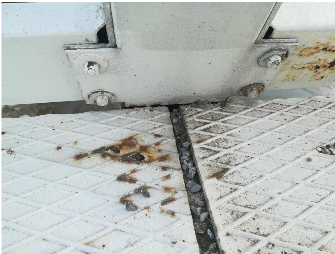
Dettaglio del collegamento dei tubolari para-piede alla base del montante tipico del parapetto
