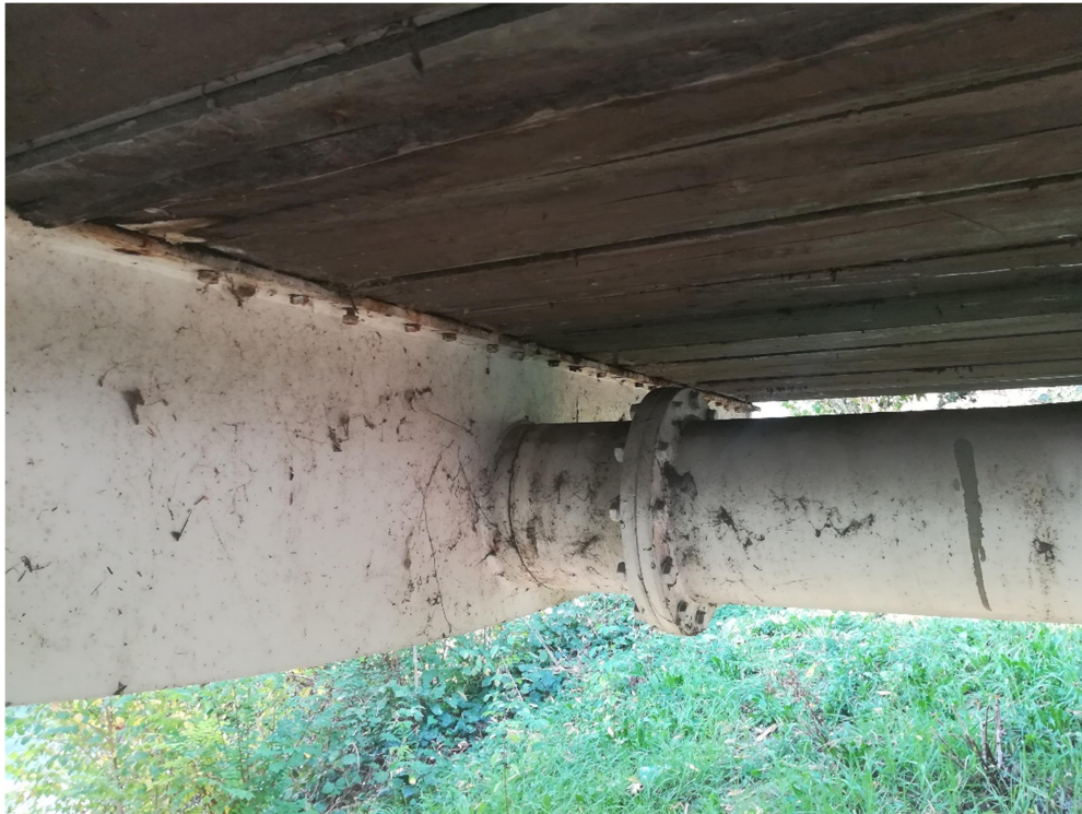
Particolare intradosso impalcato – Attacco tubo longitudinale alla gondola trasversale, appoggio delle doghe in legno sulla gondola trasversale
