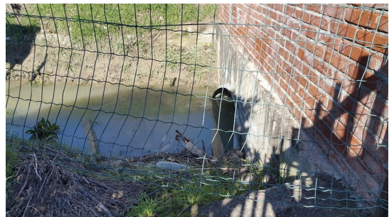
imbocco a monte
