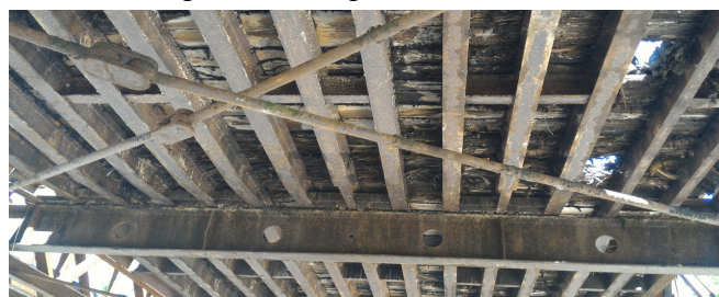
vista della struttura metallica sotto l'impalcato
