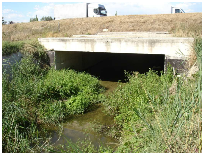
Figura 2-4 – Imbocco del canale sotterraneo del Ghironda sulla Nuova Bazzanese (lato sud). Dimensioni: circa 7 m di ampiezza per 2,5 m di altezza.
