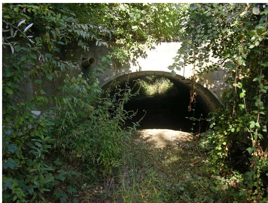
Figura 7.7 – dettaglio del sottopasso
