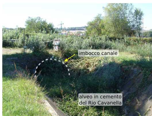
Figura 3-3– Canale sotterraneo, imbocco nord
