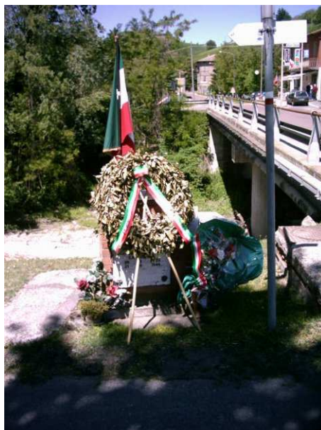
Figura 10.2 – il ponte sul T. Ghiaie di Monte Orsello (foto di mirtillause, www.panoramio.com )
