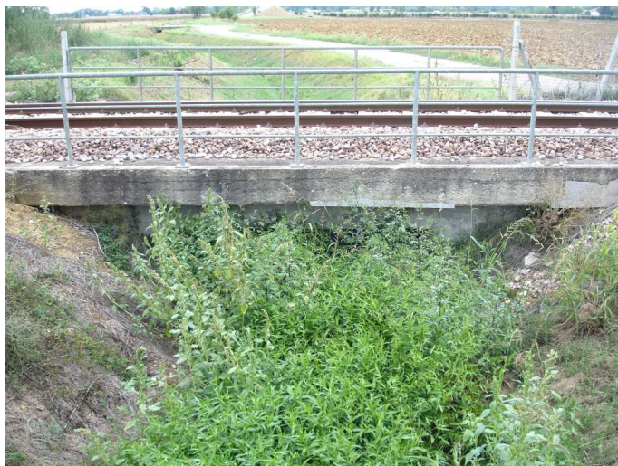
Figura 5-4 - Imbocco sud del canale sotterraneo del T. Podice sulla linea ferroviaria.
