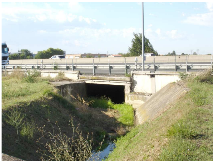
Figura 5-5- Imbocco sud del canale sotterraneo del T. Podice sulla A1. Dimensioni: circa 4 m di ampiezza per 1,5 m di altezza.
