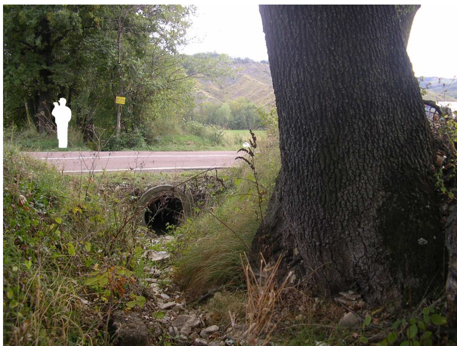
Figura 9.4 – particolare dell'attraversamento idraulico del Rio Palazzo
