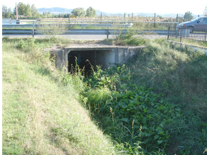
Figura 3-5 – Imbocco nord dello scatolare in cui scorre il Rio Cavanella su Via Madonna dei Prati Dimensioni: circa 2,5 m di ampiezza per 2,5 m di altezza.
