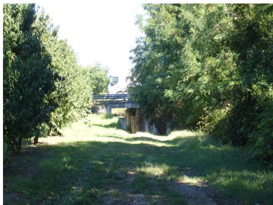
Figura 1-19 – Sottopasso A, ripreso da sud
