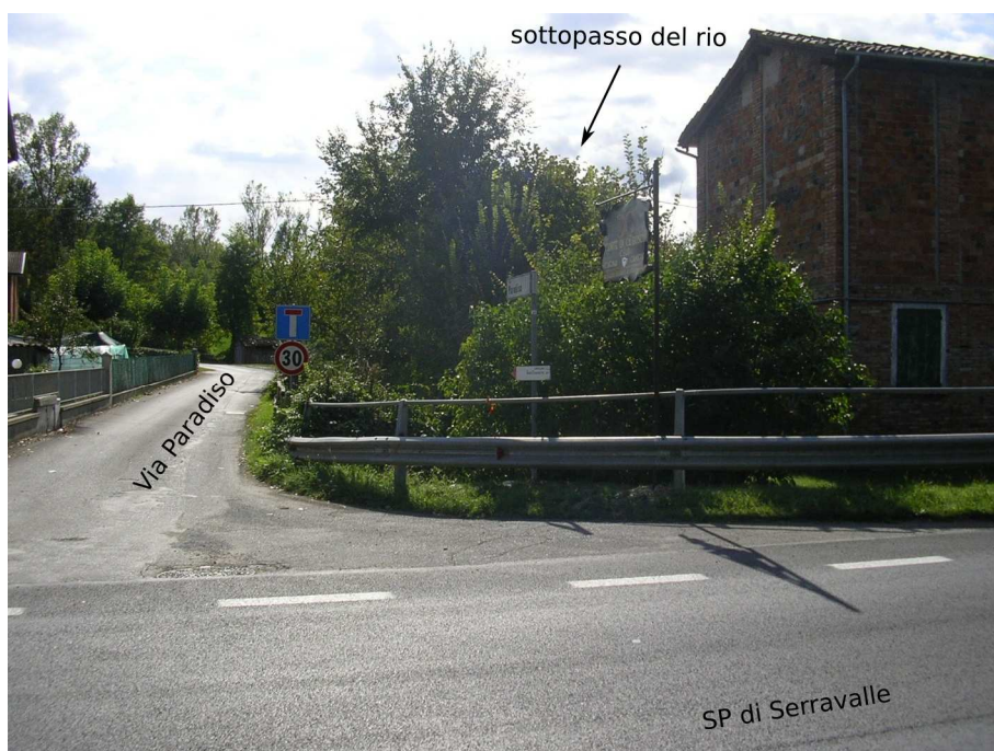
Figura 7.9 – l'area del sottopasso, guardando verso monte
