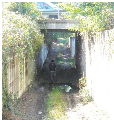
Figura 1-20– Sottopasso A, ripreso da nord
