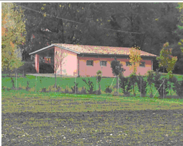
6. Capannone agricolo, Località Badia
